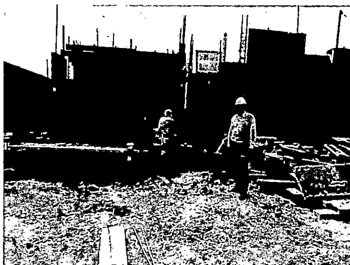
FOTO N°4: Asistente de Supervisión realizando los trabajos en campo, como verificación de la correcta ejecución de partidas.
